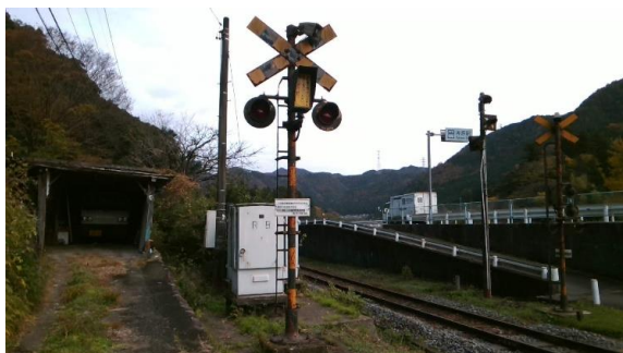
信号設備更新 第二郡上街道踏切 (施工前)
