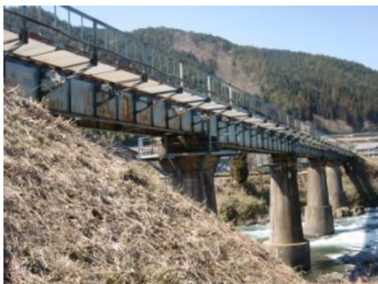
橋梁塗裝 (施工前)
