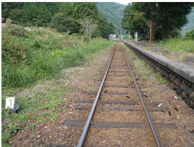
(施工後) 母野駅 レール重軌条化 ホーム嵩上げ
