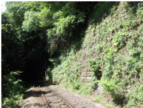
落石防護網 (施工前)
