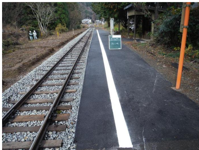
(施工後) 母野駅 レール重軌条化 ホーム嵩上げ
