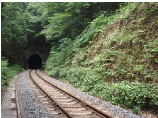
落石防護柵 (施工前)
