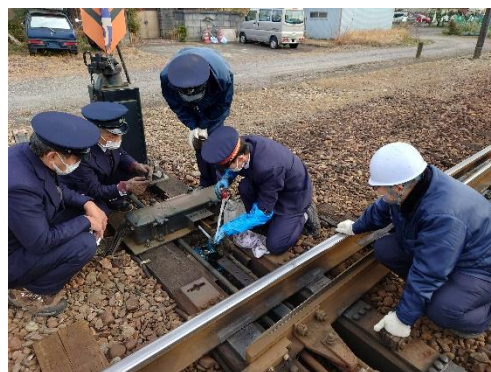
富加駅発条転てつ器転換・カンテラ設置訓練
