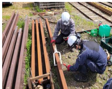
レールボンド・送着線の施工
